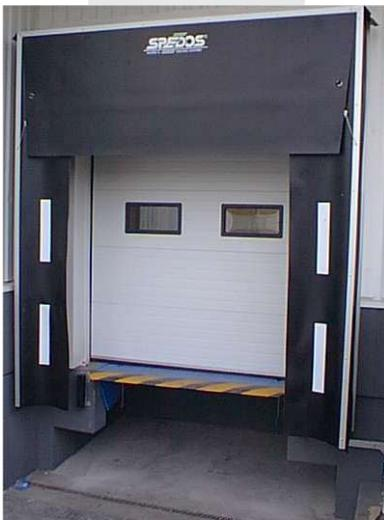
Mechanische und hydraulische Überladebrücke wird in die Verladerampe montiert. Unter der Tragfläche der mechanischer Ladebrücke ist ein kräftiges Federpaket angebracht, der als Gewichtsausgleich dient und die Bedienung per Hand ohne besonderen Kraftaufwand möglich macht
